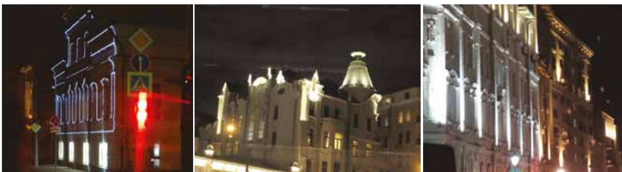
Рис. 11. Примеры плохо продуманного освещения зданий
